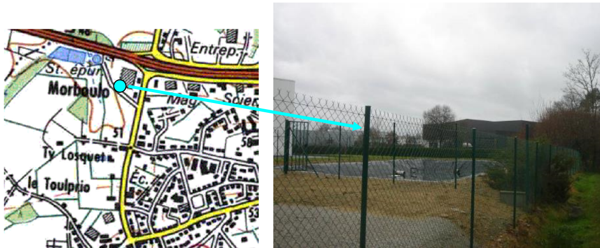
Figure 13. Bassin tampon du supermarché
