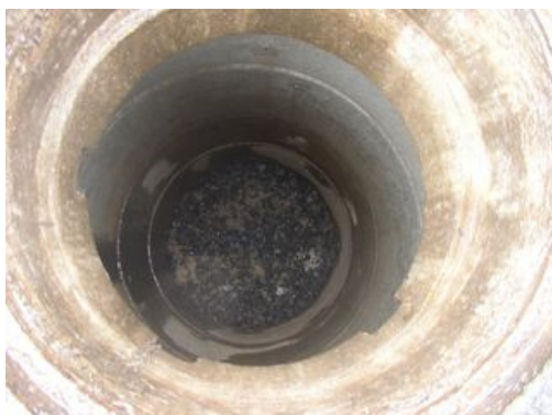
Puits d'infiltration
