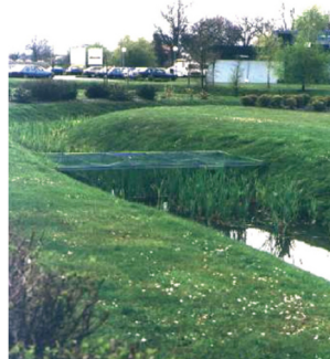
Bassin de rétention
