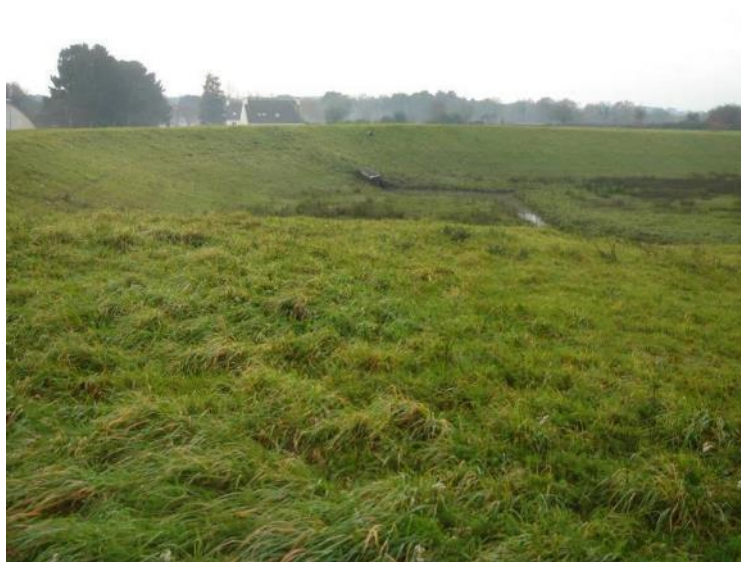
Figure 10. Bassin tampon de Luscanen
