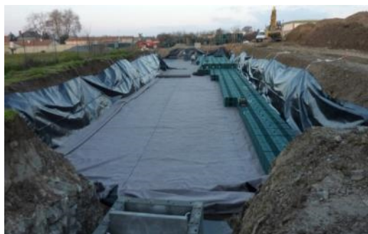
Bassin de rétention
