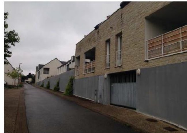
Logement intermédiaire – Surzur (56) Profitant de la pente, le stationnement est clos et semi enterré.
